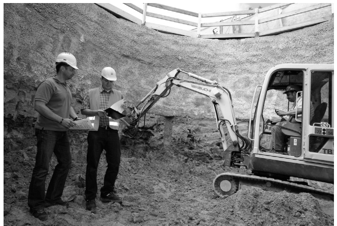
Ein wichtiger Aspekt für den Prüfingenieur beim Baustellenbesuch ist die Dokumentation der Eigenüberwachung.
