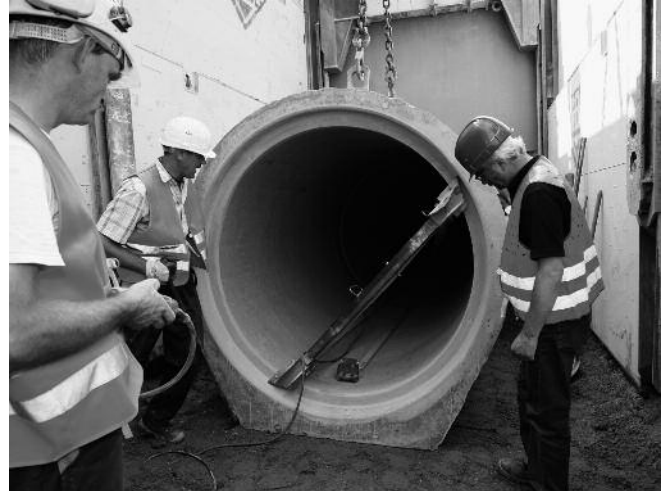
Firmen- und Baustellenbesuche – hier Dipl.-Ing. Hans-Willi Bientreu (re.) – werden ausschließlich durch vom Güteausschuss beauftragte Prüfengeure durchgeführt. Sie verfügen über Fachwissen, Praxiserfahrung und Neutralität.
