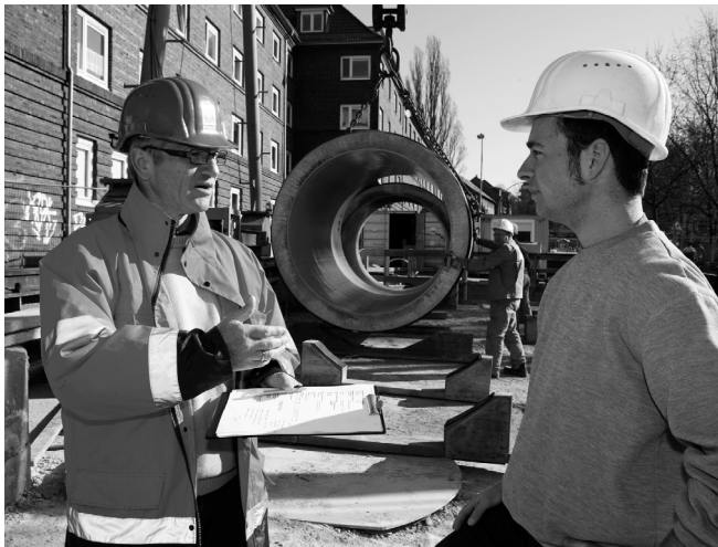
Ein vom Güteausschuss der Gütegemeinschaft Kanalbau beauftragter Prüfingenieur (li.) bei einer Besprechung vor Ort auf der Baustelle.
