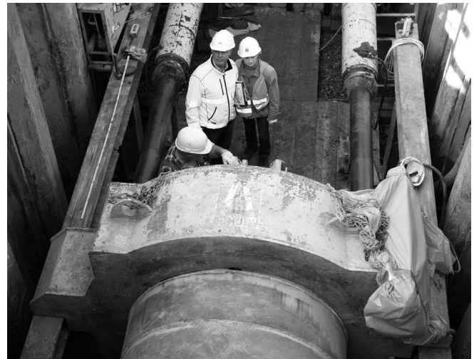
Gütezeicheninhaber melden sämtliche Baustellen. Dazu steht das System „Baustellenmeldungen Online“ zur Verfügung.
