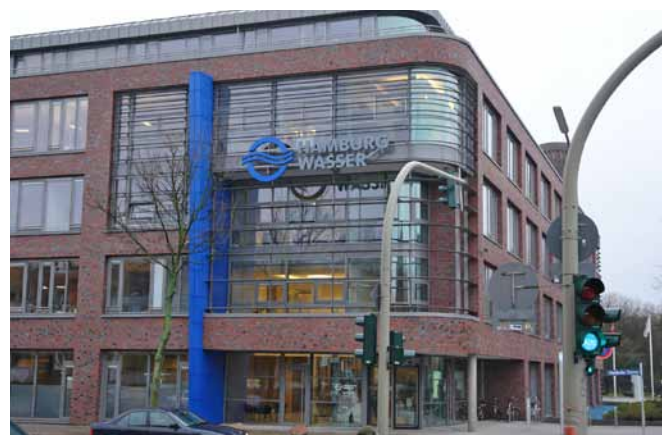
HAMBURG WASSER ist das größte kommunale Trinkwasserversorgungs- und Abwasserbeseitigungsunternehmen Deutschlands.
