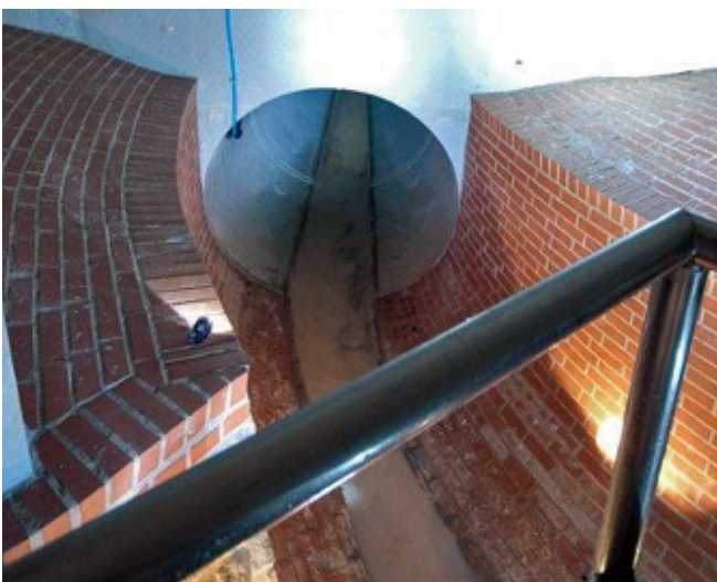
Qualität im Kanalbau: In Hamburg damals wie heute unverzichtbar.
