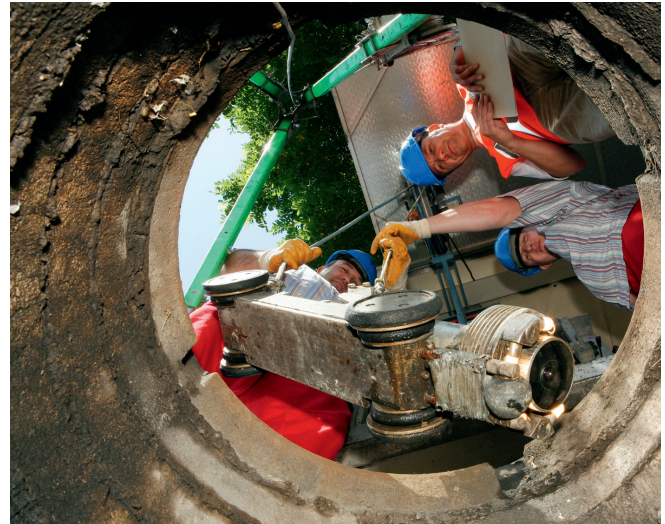
Betriebseinrichtungen und Geräte werden beim Baustellenbesuch überprüft.
