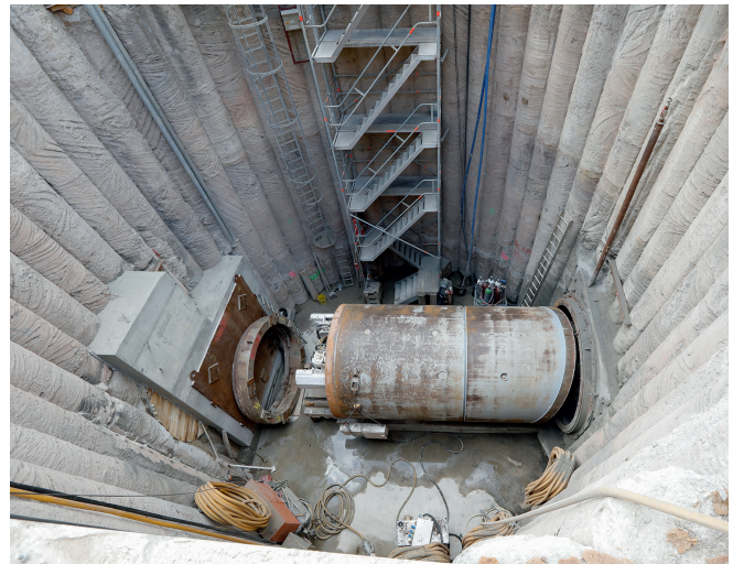
Das Widerlager in der Doppelstartbaugrube ist für den zweiten Vortrieb errichtet und die Vortriebsmaschine ausgerichtet.
