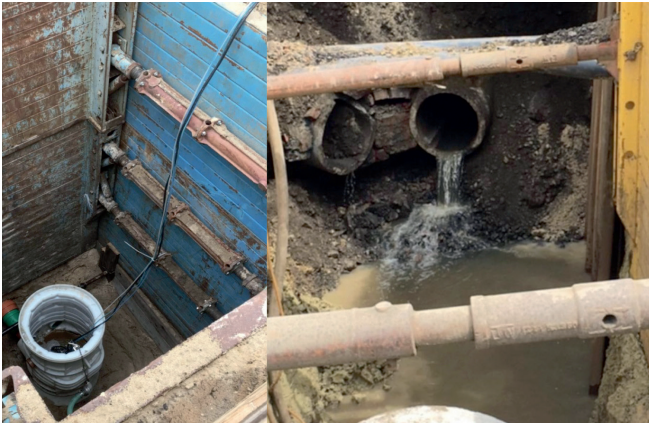
Abb. 2: Fachgerecht (l.) und unsachgemäß (r.): Keine Bagatelle – wer unbefugt ein Gewässer verunreinigt oder sonst dessen Eigenschaften nachteilig verändert, kommt mit dem Gesetz in Konflikt.
