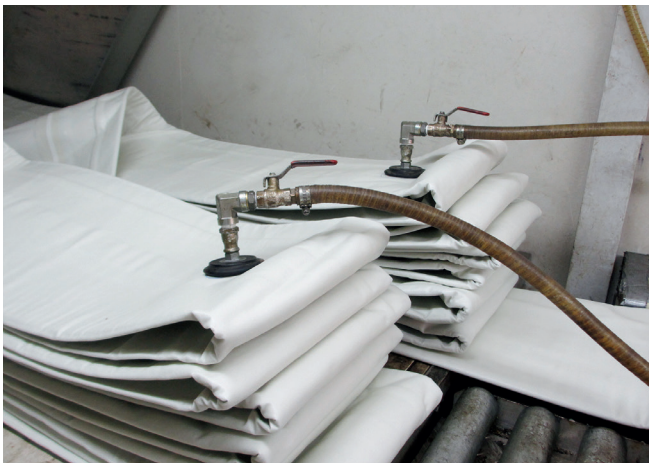
Abb. 3: Aufbringen des Vakuums vor der Tränkung der Schlauchliner mit dem Harz.
