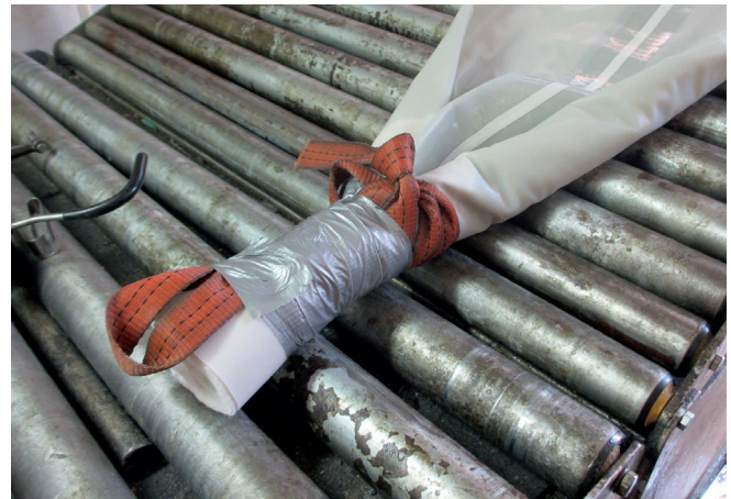
Abb. 4: Vor Abschluss der Inversion wird das Ende des Schlauchliners wasserdicht zusammengebunden.
