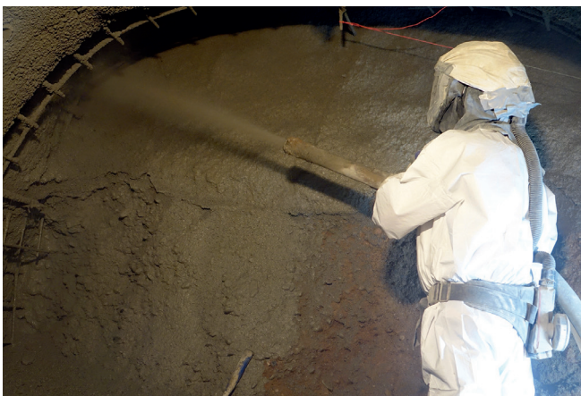
Das Auftragen des Spritzbetons erfolgt direkt an der Ortsbrust zur Sicherung des Stollens. Fotos: Güteschutz Kanalbau
