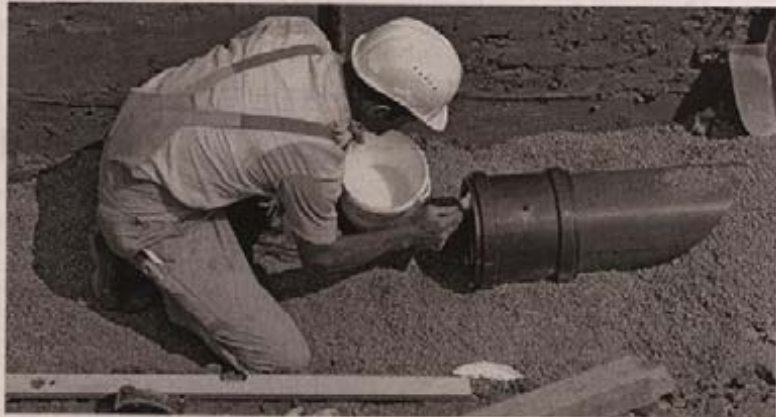
Firmen, die ein Gütezeichen Kanalbau führen, sind der geeignete Partner für den fachgerechten Einbau von Kanalrohren. Foto: Gütegemeinschaft Güteschutz Kanalbau
