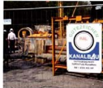
Firmen mit Gütezeichen Kanalbau bauen Kanalrohre fachgerecht ein
