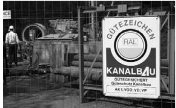
Gütegesicherte Tiefbaumaßnahme: Das Baustellenschild weist die Gütezeichen aus, die das beauftragte Unternehmen führen darf.
