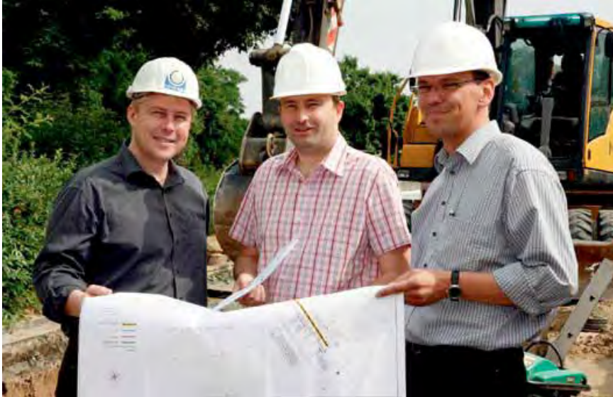
Gütesicherte Ausschreibung und Bauüberwachung sowie Ausführungsqualität bei der Neuverlegung oder Sanierung von Abwasserleitungen und -kanälen sind ein wichtiger Beitrag zur Nachhaltigkeit.
