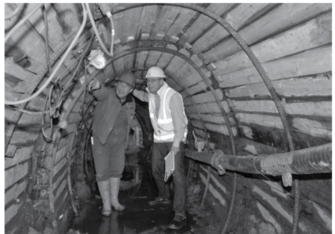
Die Gütesicherung der Gütezeicheninhaber durch Firmen- und Baustellenbesuche zählt zu den Aufgaben der Gütegemeinschaft Kanalbau.
