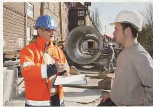
Ein vom Güteausschuss der Gütegemeinschaft Kanalbaubeauftragter Prüflingenieur bei einer Besprechung vor Ort auf der Baustelle
