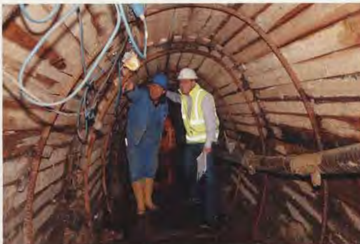
Die Gütesicherung der Gütezeicheninhaber durch Firmen- und Baustellenbesuche zählt zu den Aufgaben der Gütegemeinschaft Kanalbau.
