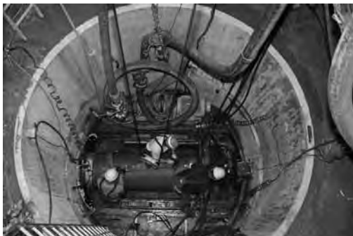
Fachgerechte Bauausführung: Zu den zentralen Aufgaben der Gütegemeinschaft zählt die Erarbeitung eines zwischen Auftraggebern, Ingenieurbüros und Auftragnehmern abgestimmten Anforderungsprofils zur Bewertung der Bieterleistung.
