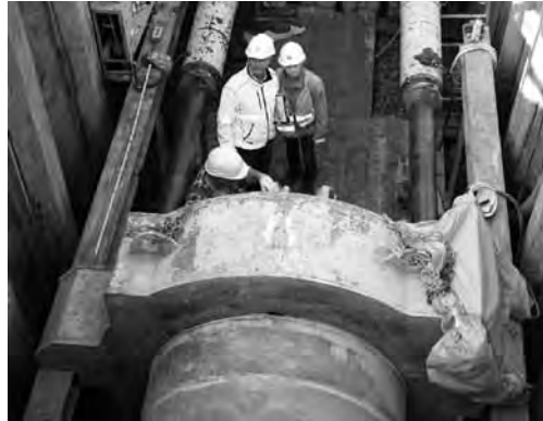
Gütezeicheninhaber melden sämtliche Baustellen. Dazu steht das System „Baustellenmeldungen Online“ zur Verfügung.
