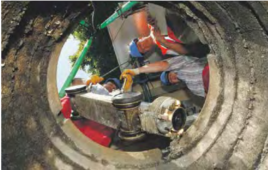
Betriebseinrichtungen und Geräte werden beim Baustellenbesuch überprüft.
