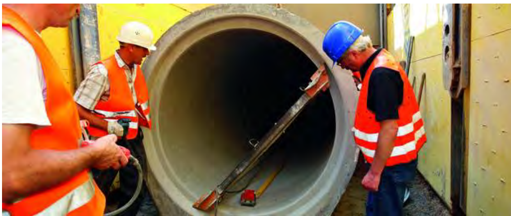
Neben der fachgerechten Ausführung der Maßnahmen beeinflussen die Ingenieurleistungen wie Planung, Ausschreibung und Bauüberwachung das Ergebnis von Kanalbaumaßnahmen. Fotos: Güteschutz Kanalbau
