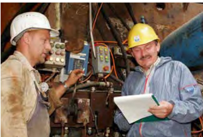
Innerhalb der RAL-Gütesicherung Kanalbau besuchen Prüflingenieurere die Baustellen der Gütezeichen führenden Unternehmen.
