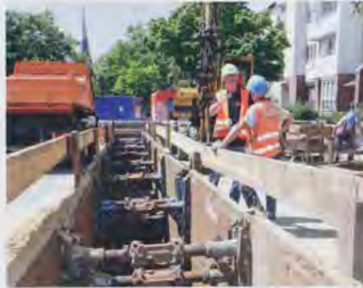
Abb. 1 Die statischen Berechnungen für Standardeinbaufälle im Online-Portal der Gütegemeinschaft Inhaber bieten eine wichtige Arbeitshilfe, um den Tragfähigkeitsnachweis der Rohre zu führen (Foto: Gütegemeinschaft Kanalbau)
