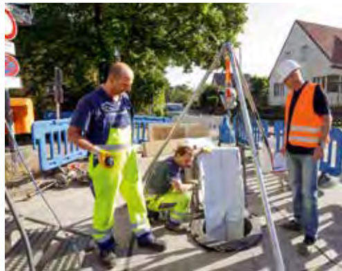
Die Prüfingenieure führen derzeit etwa 3.700 unangemeldete Baustellenbesuche pro Jahr durch, um die Qualifikation und Zuverlässigkeit der Fachfirmen zu überprüfen.
