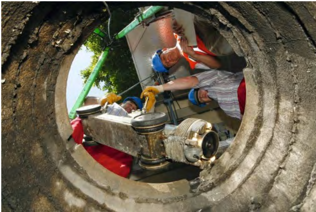
Betriebseinrichtungen und Geräte werden beim Baustellenbesuch überprüft. | Fotos: Güteschutz Kanalbau
