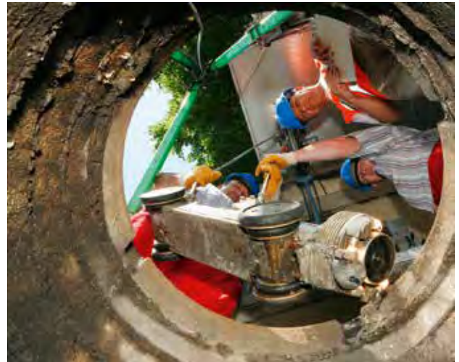
Betriebseinrichtungen und Geräte werden beim Baustellenbesuch überprüft.
