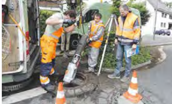
Die vom Güteausschuss beauftragten Prüfengeure führen bei den Gütezeicheninhabern derzeit jährlich ca. 6.000 Firmen- und Baustellenbesuche durch.
