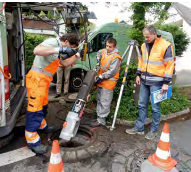
Die vom Güteausschuss beauftragten Prüfm Ingenieure führen bei den Gütezeicheninhabern derzeit jährlich ca. 6.000 Firmen- und Baustellenbesuche durch.
