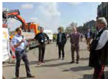
Liveinstallation eines SF-Schächtliners DN 1000
