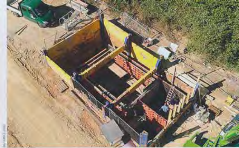
Verbau einer Baugrube zur Erstellung eines Ortbetonbauwerkes, hier als Regenüberlaufbecken (12,5 m x 7,2 m – L x B) mittels baustellenoptimierten SBH-Gleitschienensystemen und großformatigen Verbauplatten in bis zu 7 m Einzellängen. Wählweise auch komplett strebenfrei möglich. Der Verbau wurde von Bau Service Össig geplant und geliefert.
