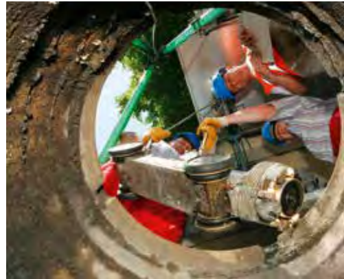
Betriebseinrichtungen und Geräte werden beim Baustellenbesuch überprüft.
