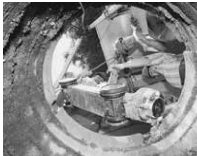
Betriebseinrichtungen und Geräte werden beim Baustellenbesuch überprüft.
