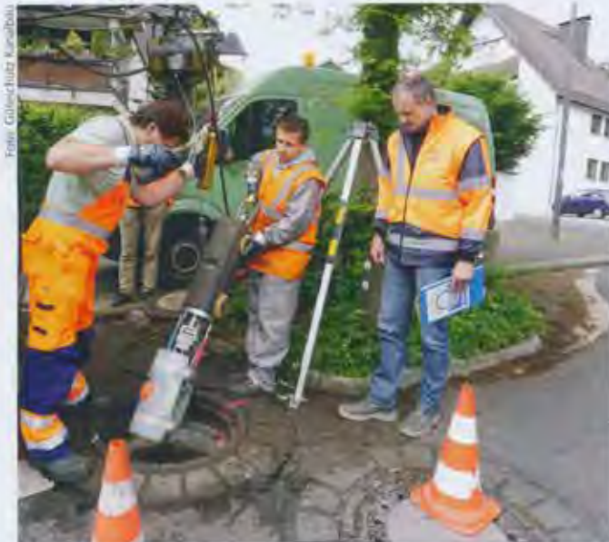
Die vom Güteausschuss beauftragten Prüfengeure führen bei den Gütezeicheninhabern derzeit jährlich ca. 6.000 Firmen- und Baustellenbesuche durch.
