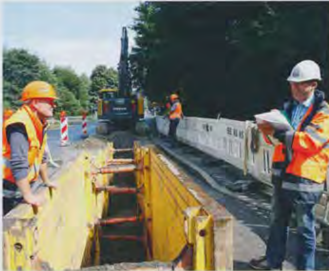
Die Qualitätssicherung von Kanalbaumaßnahmen hat einen besonders hohen Stellenwert.
