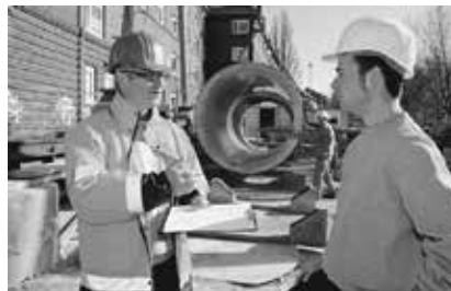
Der Einsatz von Vortriebstechnik erfordert Erfahrung und Sachverstand von allen Beteiligten.
