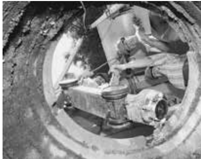
Betriebseinrichtungen und Geräte werden beim Baustellenbesuch überprüft.
