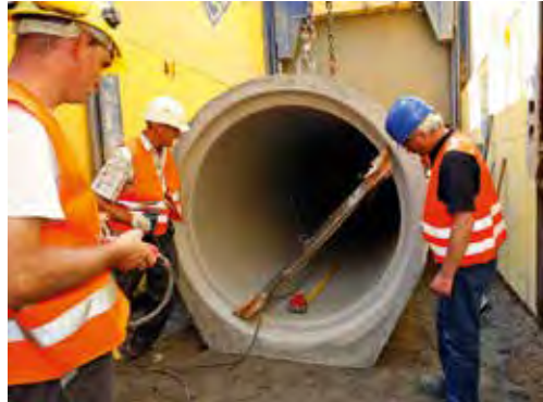
Neben der fachgerechten Ausführung der Maßnahmen beeinflussen die Ingenieurleistungen wie Planung, Ausschreibung und Bauüberwachung das Ergebnis von Kanalbaumaßnahmen.
