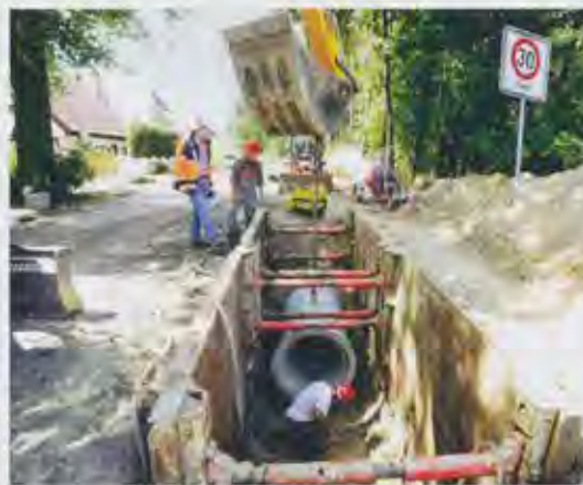
Abb. 3: Das Zusammenwirken von Bettung, Bauteil und Verfüllung ist Grundlage für die Stand- und Betriebssicherheit von Rohrleitungen (Rohr-Güteschutz Einzelbau).
