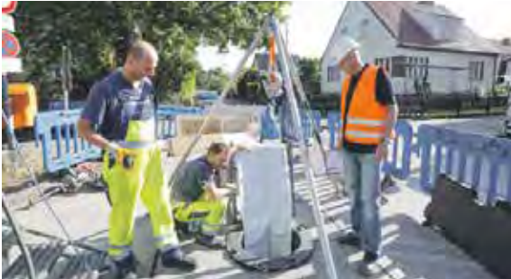
Die Prüfingenieure führen derzeit etwa 3.700 unangemeldete Baustellenbesuche pro Jahr durch, um die Qualifikation und Zuverlässigkeit der Fachfirmen zu überprüfen.
