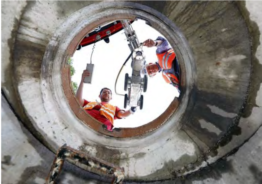
Foto: Güteschutz Kanalbau
