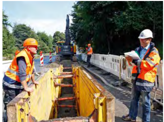
Im Fokus: Die Qualitätssicherung von Kanalbaumaßnahmen hat einen besonders hohen Stellenwert.
