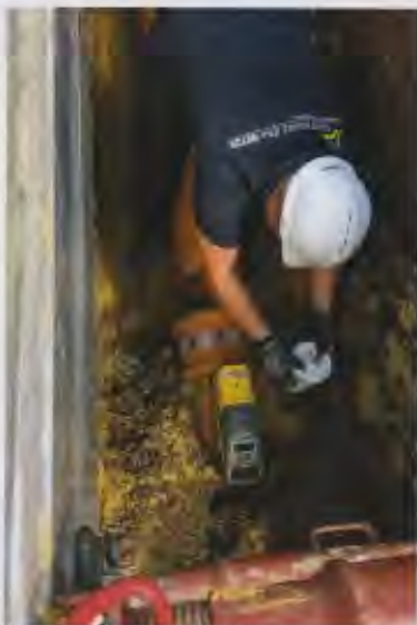
Bei Kanalbaumaßnahmen setzen die Stadtwerke Jena Netze auf Qualifikationsnachweise wie das Gütezeichen Kanalbau.
