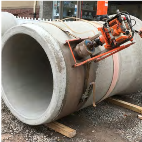
Abb. 2 – Fachgerecht (links): Das Bohrgerät ist mit Spannband fixiert und die Bohrung wird an der richtigen Stelle ausgeführt. Nicht fachgerecht (rechts): Mittig oder gegenüber hergestellte Anschlussbohrungen und deren mögliche Folgen.
