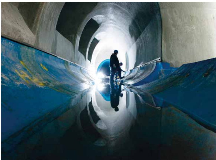
Bild 1 Sanierte Regenüberlaufbauwerke am Neustädter Abfangkanal im Stadtteil Dresden-Mickten.
