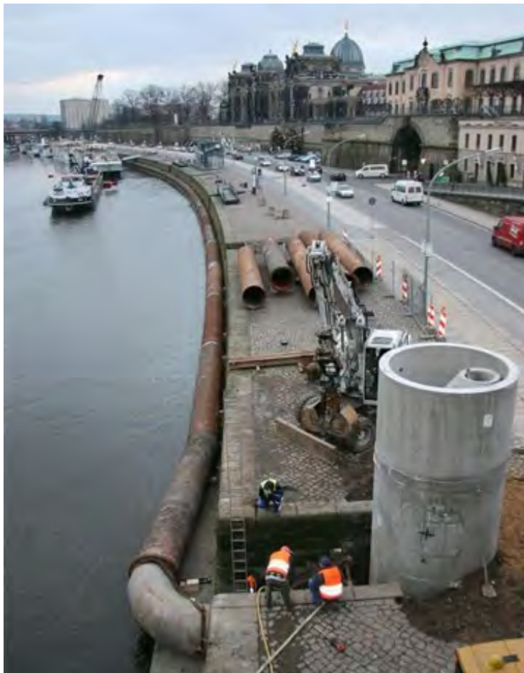
Heberleitung am Terrassenufer im Dresdner Stadtzentrum während der Sanierung des Altstädter Abfangkanals. | Foto: SEDD, 2008
