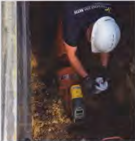
Bei Kanalbaumaßnahmen setzen die Stadtwerke Jena Netze auf Qualifikationsnachweise wie das Gütezeichen Kanalbau. Foto: Stadtwerke Jena Netze
