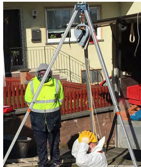
Abb. 1 – Fachgerecht (links): Eine Rettungshub-Funktion hängt an einem geeigneten Anschlagpunkt ist nur mit Haspelkettenantrieb möglich. Nicht fachgerecht (rechts): Der Anschlagpunkt ist nur für die Absturzsicherung geeignet, nicht für die Verwendung eines Höhensicherungsgerätes mit Kurbel zur Personenrettung.
