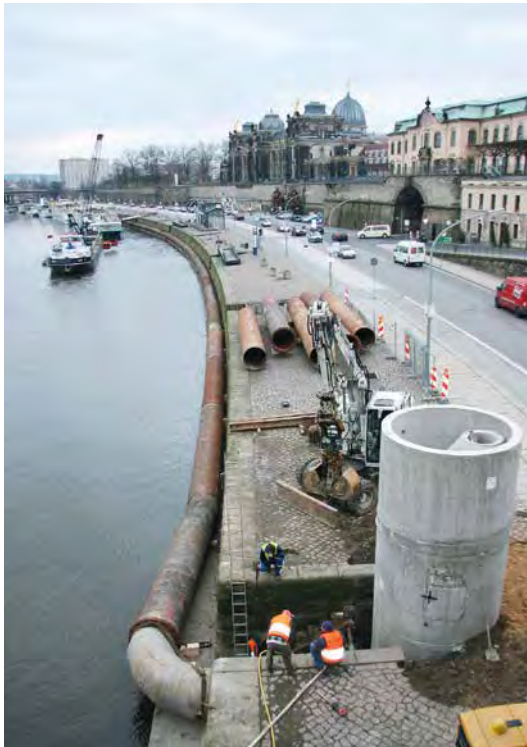
Bild 3 Heberleitung am Terrassenufer im Dresdner Stadtzentrum während der Sanierung des Altstädter Abfangkanals. Quelle: SEDD, 2008
