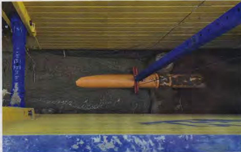
Quelle: Güteschutz Kanalbau
