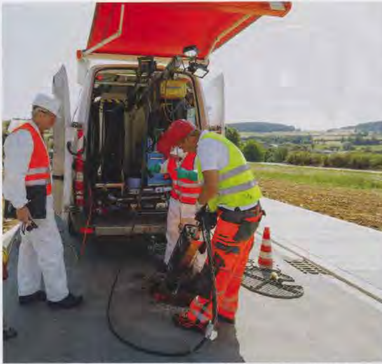
Der Prüfingenieur besucht die Baustelle: Hohe Ausführungsqualität und damit langfristig wirtschaftliche und nachhaltige Investitionen werden nur dort erreicht, wo Auftraggeber dies als klare Zielvorstellung formulieren und sich für dieses Ziel einsetzen. | Fotos: Güteschutz Kanalbau
