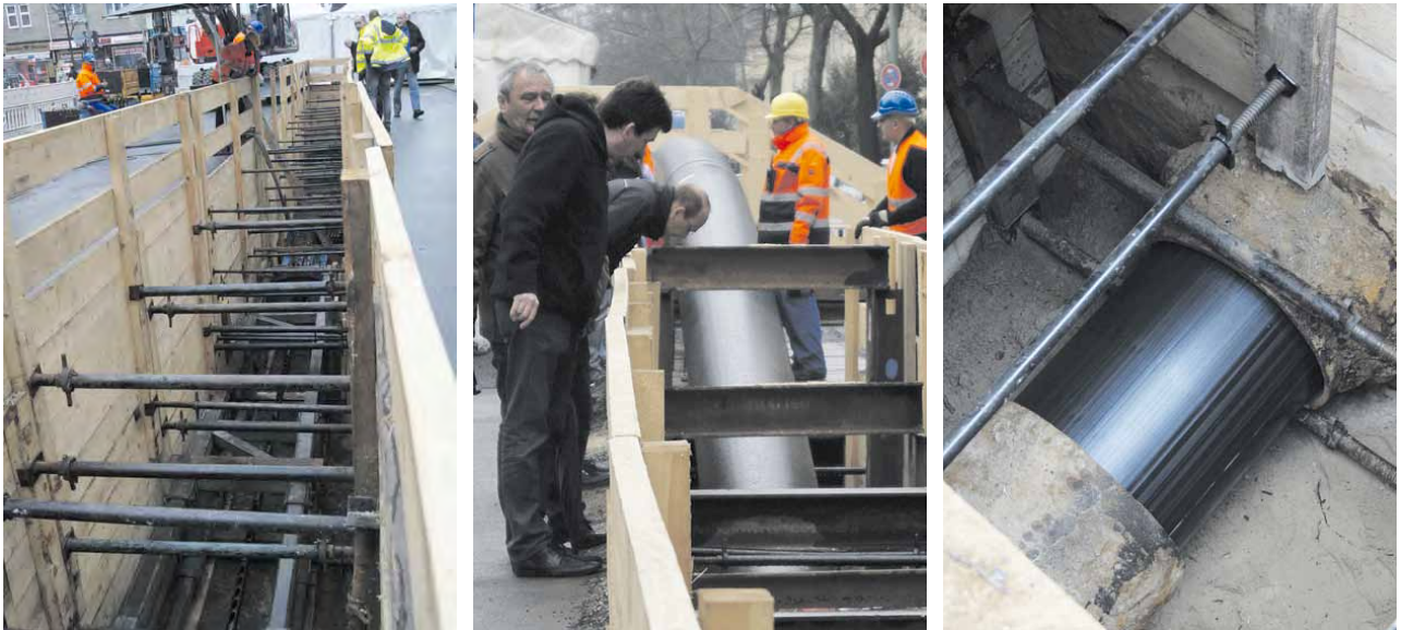
Vorausschauend arbeiten: Wer sich am Gütezeichen der Gütegemeinschaft Kanalbau bei der Auftragsvergabe orientiert, kann sich sicher sein, dass alles sitzt, wenn der Bau ausgeführt wird. Prüfungenieure sorgen für neutrale und verlässliche Kontrollen.
