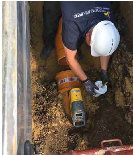
Bei Kanalbaumaßnahmen setzen die Stadtwerke Jena Netze auf Qualifikationsnachweise wie das Gütezeichen Kanalbau.
