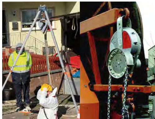
Abb. 1 und 2: Nicht fachgerecht (l.): Der Anschlagpunkt ist nur für die Absturzsicherung geeignet, nicht für die Verwendung eines Höhensicherungsgerätes mit Kurbel zur Personenrettung. Fachgerecht (r.): Eine Rettungshub-Funktion hängt an einem geeigneten Anschlagpunkt ist nur mit Haspelkettenantrieb möglich.
