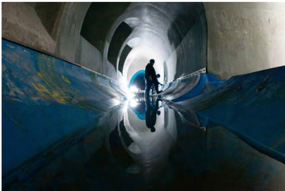
Sanierte Regenüberlaufbauwerke am Neustädter Abfangkanal im Stadtteil Dresden-Mickten. | Foto: SEDD, 2020
