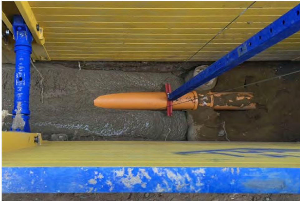
Der Einsatz von Flüssigboden nimmt zu. Was bei seiner Verwendung auf der Baustelle beachtet werden muss, darüber informiert ein neuer Leitfaden Eigenüberwachung der Gütegemeinschaft Kanalbau. | Foto und Abbildungen: Güteschutz Kanalbau
