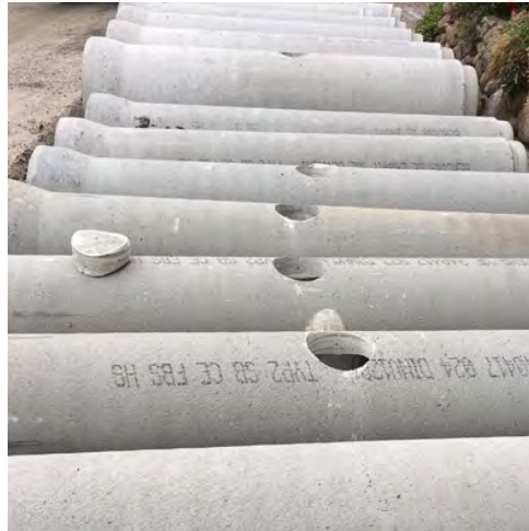
Abb. 2 – Fachgerecht (links): Das Bohrgerät ist mit Spannband fixiert und die Bohrung wird an der richtigen Stelle ausgeführt. Nicht fachgerecht (rechts): Mittig oder gegenüber hergestellte Anschlussbohrungen und deren mögliche Folgen.
