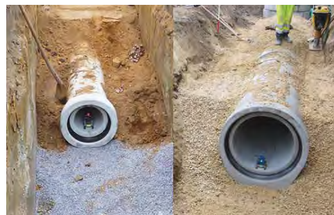
Bild 5. Unsachgemäß bzw. fachgerecht: Unterschiedliche Materialien für untere und obere Bettungsschicht (l.). Einheitliches Material für die Bettung (r.).
