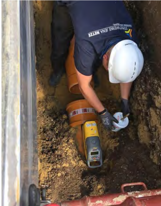
Bei Kanalbaumaßnahmen setzen die Stadtwerke Jena Netze auf Qualifikationsnachweise wie das Gütezeichen Kanalbau. | Foto: Stadtwerke Jena Netze
