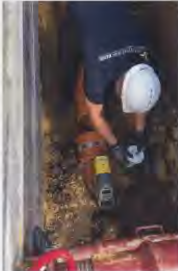
Bei Kanalbaumaßnahmen setzen die Stadtwerke Jena Netze auf Qualifikationsnachweise wie das Gütezeichen Kanalbau. | Foto: Stadtwerke Jena Netze
