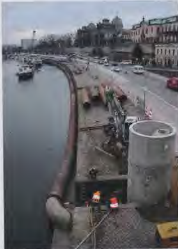
Heberleitung am Terrassenufer im Dresdner Stadtzentrum während der Sanierung des Altstädter Abfängkanals. | Foto: SEDD, 2008
