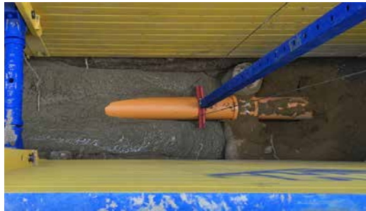
Bild 1: Der Einsatz von Flüssigboden nimmt zu. Was bei seiner Verwendung auf der Baustelle beachtet werden muss, darüber informiert ein neuer Leitfaden Eigenüberwachung der Gütegemeinschaft Kanalbau
