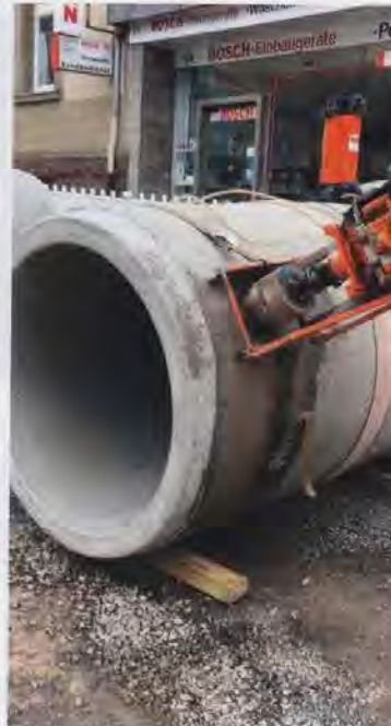
Nicht fachgerecht (l.); mittig oder gegenüber hergestellte Anschlussbohrungen und deren mögliche Folgen. Fachgerecht (r.): Das Bohrgerät ist mit Spannbänder fixiert und die Bohrung wird an der richtigen Stelle ausgeführt. | Fotos: Güteschutz Kanalbau
