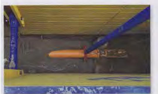
16 Güteschutz Kanalbau bringt Leitfaden zu Flüssigboden heraus
