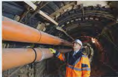
Prüfingenieur Marc Mielke überzeugt sich vor Ort von der fachgerechten Ausführung des Stahlverzuges.
