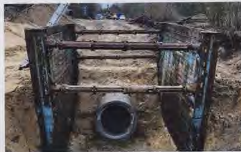
Bild 2: Eine der Referenzbaustellen der antragstellenden AS+BE Asphalt- und Betonstraßenbau GmbH
