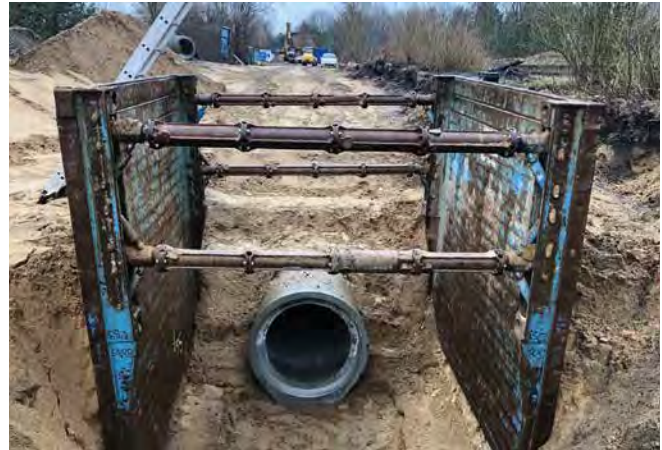
Eine der Referenzbaustellen der antragstellenden AS+BE Asphalt- und Betonstraßenbau GmbH.
