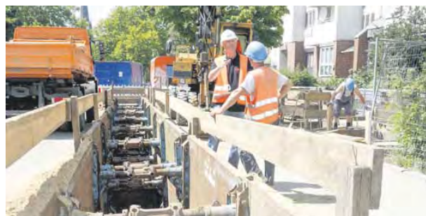
Entsprechend der Güte- und Prüfbestimmungen besuchen die Prüflingenieure regelmäßig die Baustellen der Mitgliedsunternehmen.
