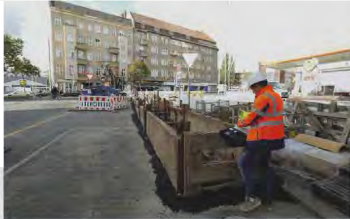
Foto: Güteschutz Kanalbau
