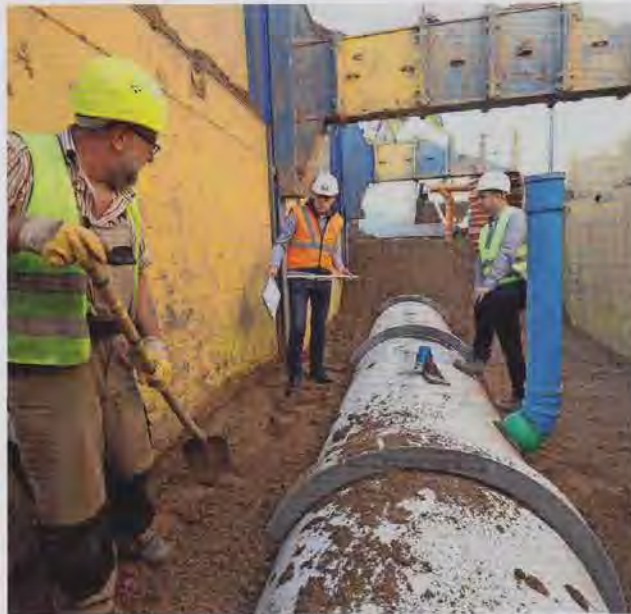
Foto: Güteschutz Kanalbau
