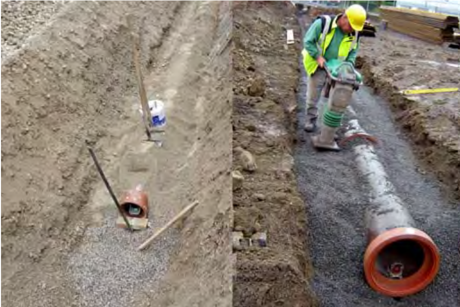
Foto: Güteschutz Kanalbau
