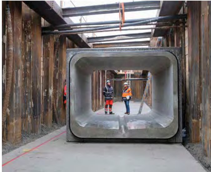
Ein wichtiger Bestandteil der Gütesicherung ist die Überprüfung der Gütezeicheninhaber durch einen unabhängigen Prüfingenieur, der vom Güteausschuss des Güteschutz Kanalbau beauftragt ist.
