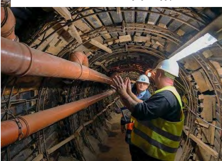
ARGE-Polier Ingo Heidgen erläutert Prüfingenieur Marc Mielke die Vorgehensweise beim Umschluss der Hausanschlussleitungen an die provisorische Abwasserleitung. | Foto: Sabine Grothues
