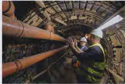
Bild 2: Prüflingenieur Marc Mielke (hinten) überzeugt sich vor Ort von der fachgerechten Ausführung des Stahlverzuges
