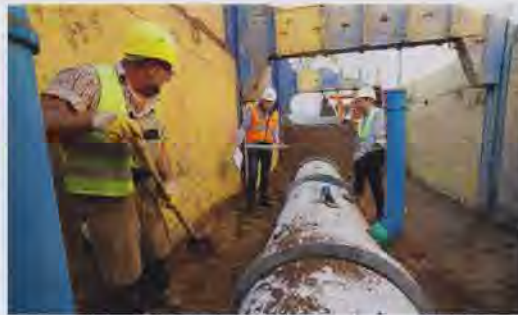
Auf die fachgerechte Ausführung der Verdichtung von Rohrbettung, Seitenverfüllung oder Abdeckung ist im Zuge der Eigenüberwachung besonderes Augenmerk zu legen.
