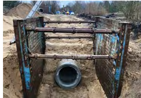
Eine der Referenzbaustellen der antragstellenden AS+BE Asphalt- und Betonstraßenbau GmbH.
