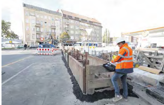
Stephan Tolkmitt gehört zu den Prüfingenieuren, die in vorgegebenen Abständen die Baustellen der Gütezeichen führenden Unternehmen besuchen.
