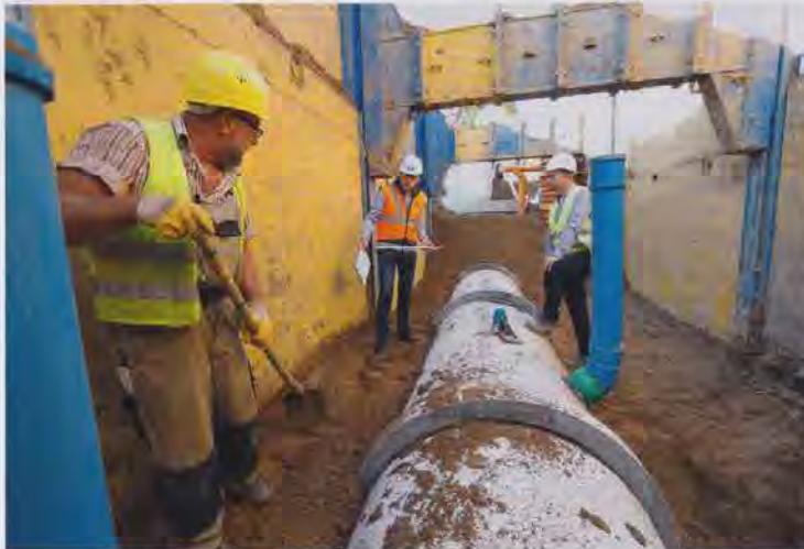
Auf die fachgerechte Ausführung der Verdichtung von Rohrbettung, Seitenverfüllung oder Abdeckung ist im Zuge der Eigenüberwachung besonderes Augenmerk zu legen.
