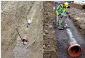
Bild 3 Angeschütteter, nicht verdichteter Bereich der Leitungszone und der Abdeckung (l.); Lagenweiser Einbau Verdichtung über die gesamte Grabenbreite (r.).
