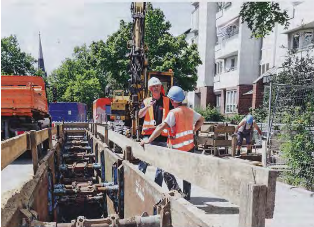
Abb.: Güteschutz Kanalbau
