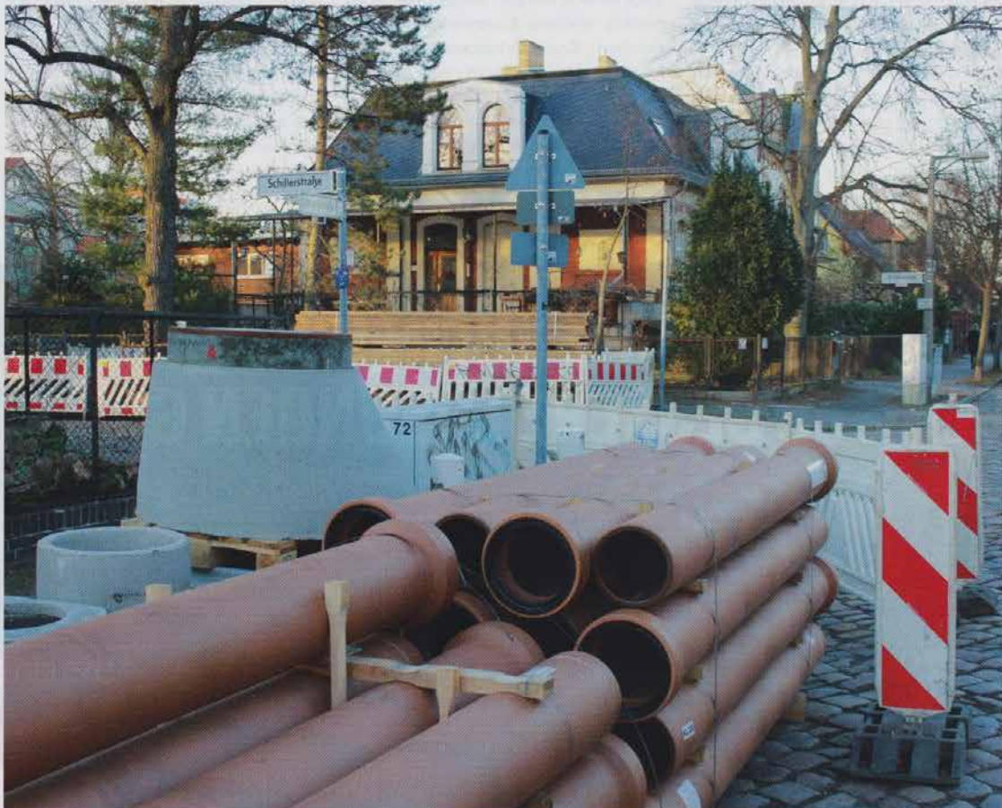
Bild 1 Die fachgerechte Bauausführung entscheidet über die Nutzungsdauer der verlegten Rohre.
