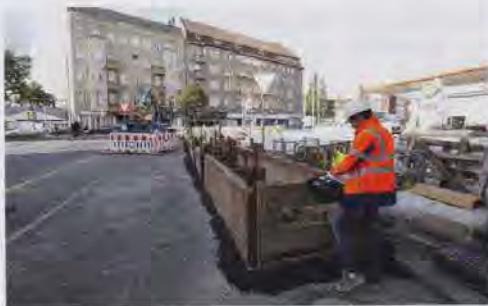
Bild 1: Stephan Tolkmitt gehört zu den Prüfingenieuren, die die Baustellen der Gütezeichen-führenden Unternehmen besuchen
