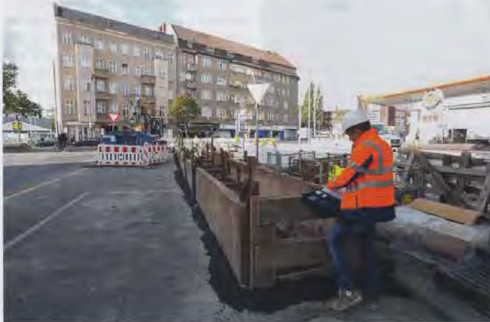
Stephan Tolkmitt gehört zu den Prüffingenieuren, die in vorgegebenen Abständen die Baustellen der Gütezeichen führenden Unternehmen besuchen. | Fotos: Güteschutz Kanalbau
