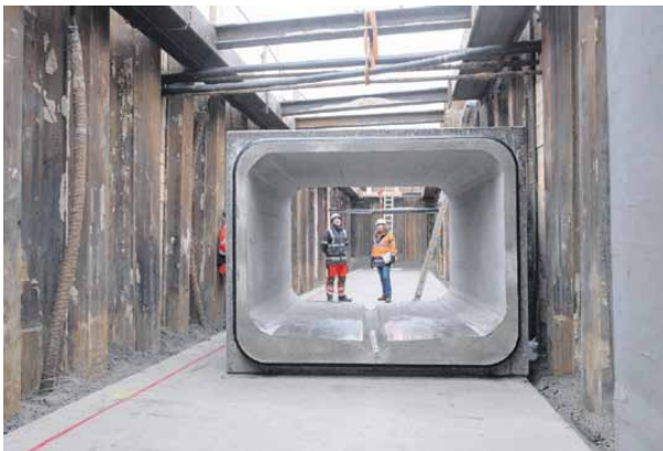
Ein wichtiger Bestandteil der Gütesicherung ist die Überprüfung der Gütezeicheninhaber durch einen unabhängigen Prüfenieur, der vom Güteausschuss des Güteschutz Kanalbau beauftragt ist.
