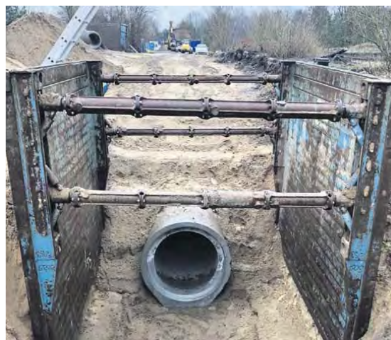
Eine der Referenzbaustellen der antragstellenden AS+BE Asphalt- und Betonstraßenbau GmbH.
