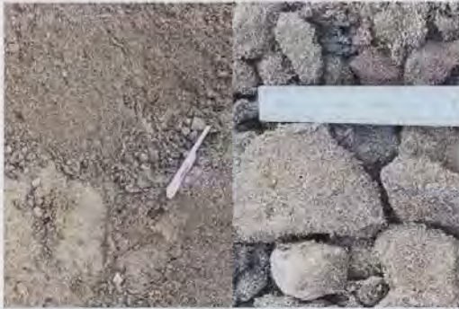
Material aus dem Schaufelseparator in der Leitungszone (l.); Überkorn in der Leitungszone (r.)
