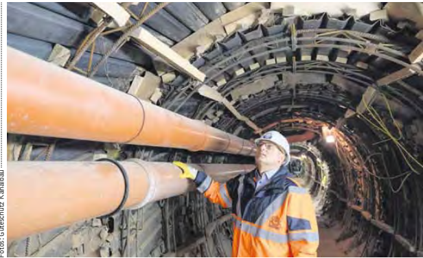
Prüflingenieur Marc Mielke überzeugt sich vor Ort von der fachgerechten Ausführung des Stahlverzuges.
