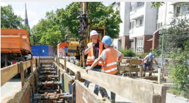
Bild 1 Entsprechend der Güte- und Prüfbestimmungen besuchen die Prüfindenieure regelmäßig die Baustellen der Mitgliedsunternehmen.
