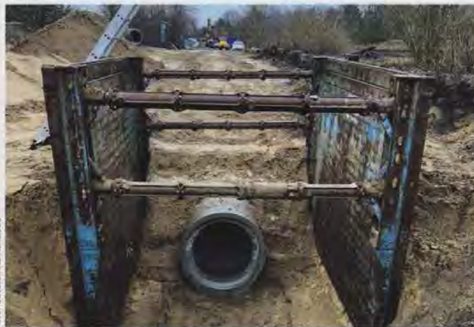
Foto: Güteschutz Kanalbau
