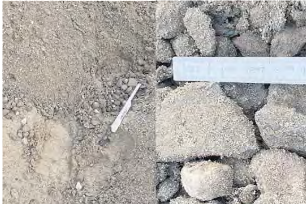
Material aus dem Schaufelseparator in der Leitungszone (l.);
