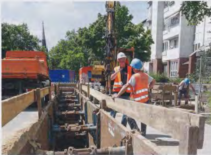
Entsprechend den Güte- und Prüfbestimmungen besuchen die Prüflingenieure regelmäßig die Baustellen der Mitgliedsunternehmen.
