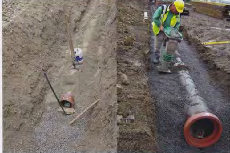
Links: Angeschütteter, nicht verdichteter Bereich der Leitungszone und der Abdeckung; rechts: lagenweiser Einbau, Verdichtung über die gesamte Grabenbreite | Fotos: Güteschutz Kanalbau
