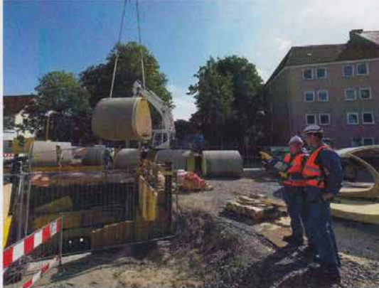
Bild 3: Die GFK-Rohre werden mit einem Kran in die Baugrube abgelassen und von dort mit einem speziellen Fahrwagen in die Lutter-Verrohrung eingefahren. Alexander Garen (Umweltbetrieb der Stadt Bielefeld, re.) und Prüflingenieur Guido Heidbrink (Güteschutz Kanalbau, li.) besprechen den Sanierungsfortschritt.
