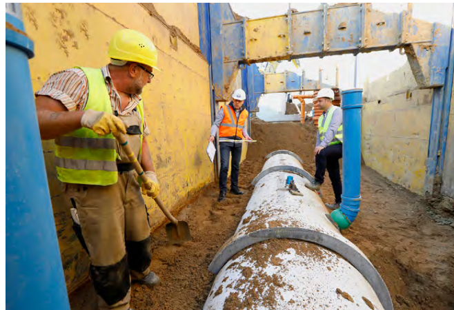
Bild 1: Auf die fachgerechte Ausführung der Verdichtung von Rohrbettung, Seitenverfüllung oder Abdeckung ist im Zuge der Eigenüberwachung besonderes Augenmerk zu legen
