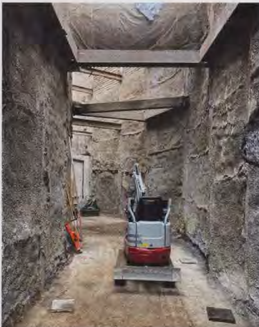
Bild 1: In rund 7,5 m Tiefe erfolgen die Arbeiten zum Umbau und der Erweiterung des SKU. Gut zu erkennen ist eine der beiden kreuzenden Ferngasleitungen, in deren Schutzbereich alle Arbeiten erschütterungsfrei erfolgen müssen
