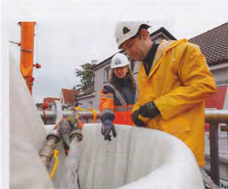
Bei den unangemeldeten Baustellenbesuchen begutachten die Prüflingenieure die Qualifikation und Zuverlässigkeit der Fachunternehmen. Dabei werden entsprechend den allgemein anerkannten Regeln der Technik die Ausführung der Maßnahme, die personelle und maschinentechnische Ausstattung sowie die Eigenüberwachung geprüft. | Foto: Güteschutz Kanalbau
