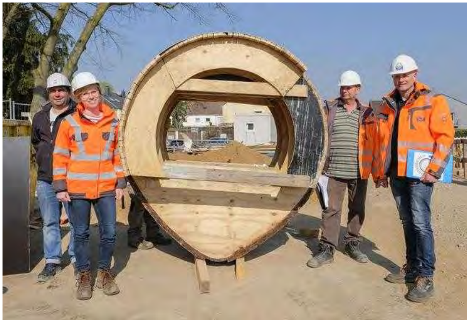
Ein produktives Miteinander für ein erfolgreiches Projekt (v.l.n.r.): Thomas Schacht (Stadtentwässerungsbetriebe Köln AöR), Britta Heitkamp und Uwe Zimmer (beide Heitkamp IB) und Prüfenieur Joachim Oligschläger (Güteschutz Kanalbau). | Foto: Güteschutz Kanalbau
