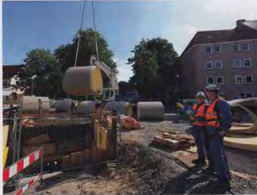
Bild 3: Die GFK-Rohre werden mit einem Kran in die Baugrube abgelassen und von dort mit einem speziellen Fahrwagen in die Lutter-Verrohrung eingefahren. Alexander Garen (Umweltbetrieb der Stadt Bielefeld), Johannes Leewe (Aarsleff Rohrsanierung), Guido Heidbrink (Güteschutz Kanalbau, re.) und Prüflingenieur Guido Heidbrink (Güteschutz Kanalbau, li.) besprechen den Sanierungsfortschritt.
