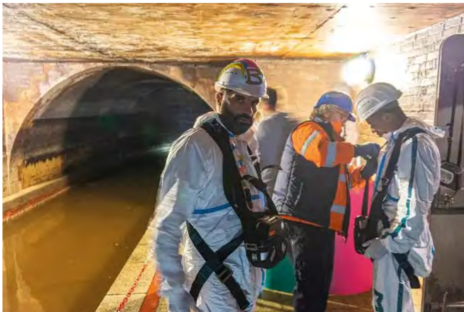
Arbeitssicherheit geht vor: der Sielmeister prüft den Sitz der „Selbstretter“ | Foto: mama burns – Ben Bockelmann
