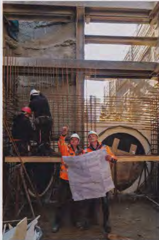
Bild 3: Baustellenbesuche vor Ort gehören zur Qualitätssicherung dazu: Dipl.-Ing. Joachim Oligschläger (re.) überzeugt sich im Gespräch mit Heitkamp-Bauleiter Dipl.-Ing. Uwe Zimmer, dass bei dem Bau des Verbindungsbauwerkes alle Vorgaben eingehalten werden
