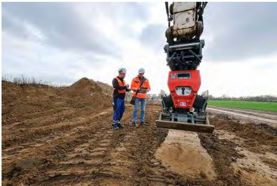
Zentrales Element der Qualitätssicherung: Verdichtungsprüfungen | Foto: Güteschutz Kanalbau
