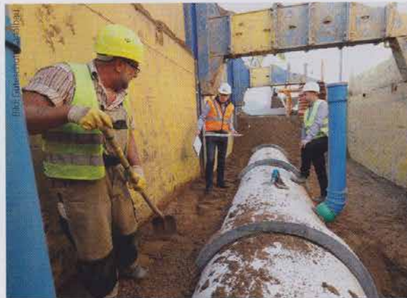
Bild 1: Auf die fachgerechte Ausführung der Verdichtung von Rohrbettung, Seitenverfüllung oder Abdeckung ist im Zuge der Eigenüberwachung besonderes Augenmerk zu legen.
