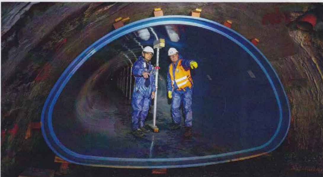
Bild 5: Die GFK-Rohre werden mit Hilfe von Ziegelsteinen und Holzkeilen in ihrer Lage gesichert. Die Baustützen verhindern ein Aufwölben des Sohlbereiches während der Ringraumverdümmung. Im Gespräch Aarsleff Oberbauleiter Johannes Leewe (li.) und Güteschutz Prüflingenieur Guido Heidbrink (re.).
