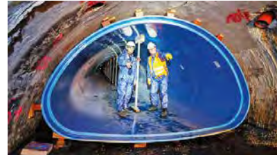
Die GFK-Rohre werden mit Hilfe von Ziegelsteinen und Holzkeilen in ihrer Lage gesichert. Die Baustützen verhindern ein Aufwölben des Sohlbereiches während der Ringraumverdrämmung. Im Gespräch Aarsleff Oberbauleiter Johannes Leewe (l.) und Güteschutz-Prüfingenieur Guido Heidbrink (r.). Bild: Güteschutz Kanalbau
