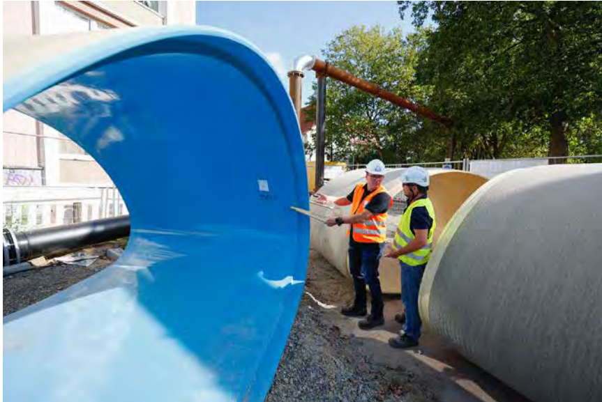
Unterschiedliche Rohrdimensionen: Güteschutz Prüfenieur Guido Heidbrink (l.) überprüft zusammen mit Aarsleff Oberbauleiter Johannes Leewe die Wandstärke der GFK-Rohre. Foto: Güteschutz Kanalbau
