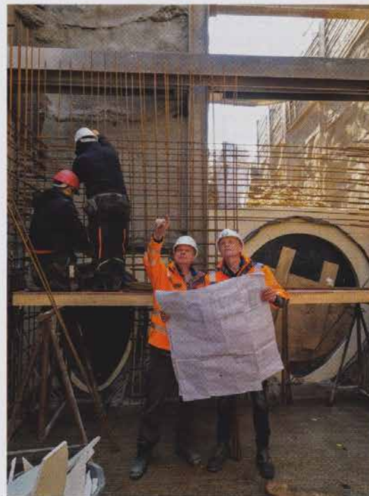
Bild 3: Baustellenbesuche vor Ort gehören zur Qualitätssicherung dazu: Dipl.-Ing. Joachim Ollgschläger (re.) überzeugt sich im Gespräch mit Heitkamp-Bauleiter Dipl.-Ing. Uwe Zimmer, dass bei dem Bau des Verbindungsbauwerkes alle Vorgaben eingehalten werden.
