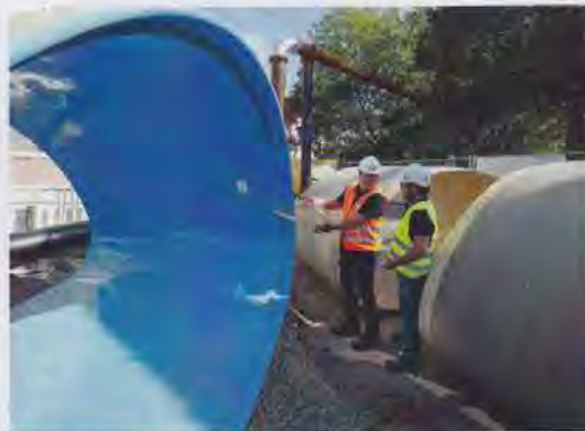
Bild 2: Unterschiedliche Rohrdimensionen: Güteschutz-Prüfingenieur Guido Heidbrink (li.) überprüft zusammen mit Aarsleff Oberbauleiter Johannes Leewe die Wandstärke der GFK-Rohre.
