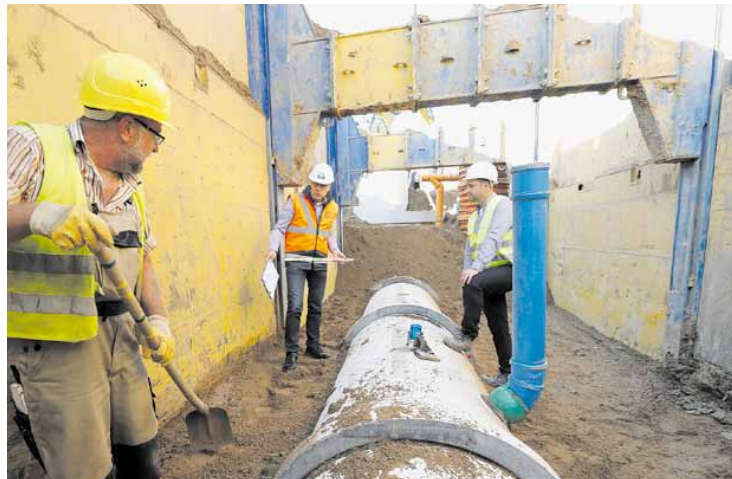
Auf die fachgerechte Ausführung der Verdichtung von Rohrbettung, Seitenverfüllung oder Abdeckung ist im Zuge der Eigenüberwachung ein besonderes Augenmerk zu legen.
