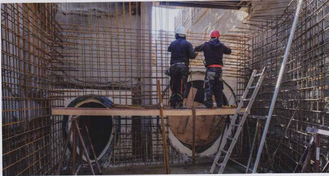
Bild 4: In dem Verbindungsbauwerk treffen der alte Entlastungskanal (Eipprofil 800/1400, li. im Bild) und der neu errichtete, zusätzliche Entlastungskanal (1700/1890, re.) zusammen. Von hier führt der Entlastungskanal in der Dimension 2000/2225 zu dem Hochwasserdoppelschieber.
