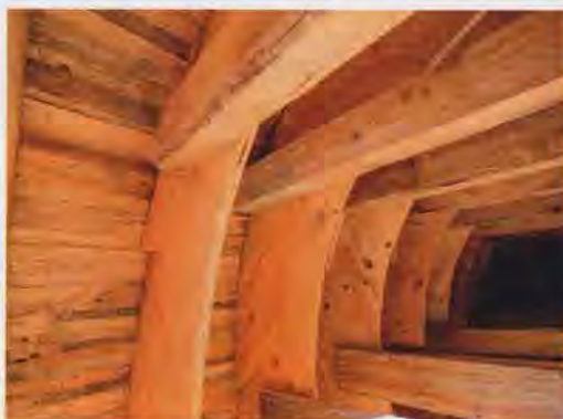
Ein Blick in die Schalung des neuen Entlastungskanals 2000/2225 zeigt die umfangreiche Handarbeit. Foto: Güteschutz Kanalbau
