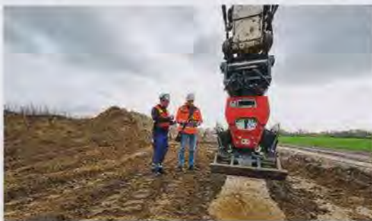
Bild 4. Beim Baustellenbesuch bewertet der Prüflingenieur unter anderem auch die Eigenüberwachung. (Abbildungen 1, 2, 4: Güteschutz Kanalbau)
