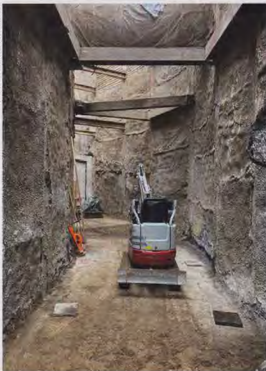
Bild 1: In rund 7,5 m Tiefe erfolgen die Arbeiten zum Umbau und der Erweiterung des SKU. Gut zu erkennen ist eine der beiden kreuzenden Ferngasleitungen, in deren Schutzbereich alle Arbeiten erschütterungsfrei erfolgen müssen.
