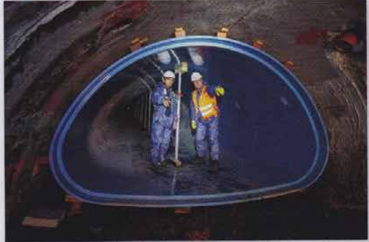
45 Hohe Qualitätsstandards standen bei einer herausfordernden Sanierungsmaßnahme in Bielefeld im Fokus
