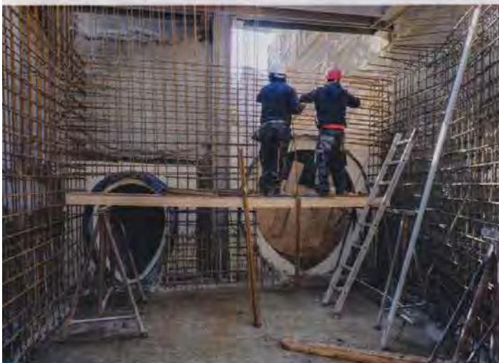
In dem Verbindungsbauwerk treffen der alte Entlastungskanal (Eiprofil 800/1400, links im Bild) und der neu errichtete, zusätzliche Entlastungskanal (1700/1890, rechts) zusammen.
