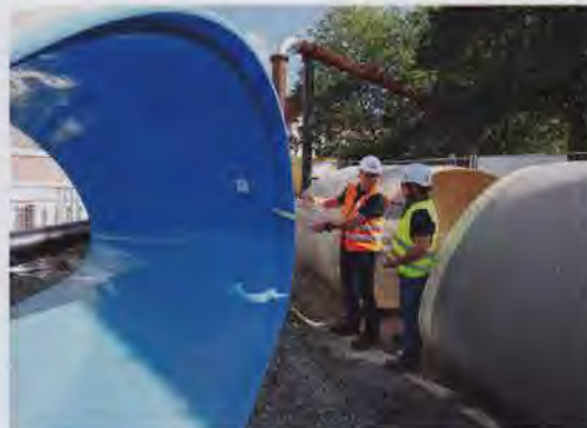
Bild 2: Unterschiedliche Rohrdimensionen: Güteschutz-Prüfingenieur Guido Heidbrink (li.) überprüft zusammen mit Aarsleff Oberbauleiter Johannes Leewe die Wandstärke der GFK-Rohre.
