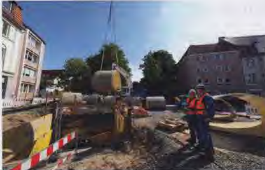
Die GFK-Rohre werden mit einem Kran in die Baugrube abgelassen und von dort mit einem speziellen Fahrwagen in die Lutter-Verrohrung eingefahren. Alexander Garen (Umweltbetrieb der Stadt Bielefeld), Johannes Leewe (Aarsleff Rohrsanierung), Guido Heidbrink (Güteschutz Kanalbau, links) besprechen den Sanierungsfortschritt.
