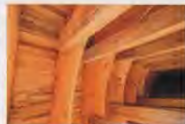
Ein Blick in die Schalung des neuen Entlastungskanals 2000/2225 zeigt die umfangreiche Handarbeit. | Fotos: Güteschutz Kanalbau
