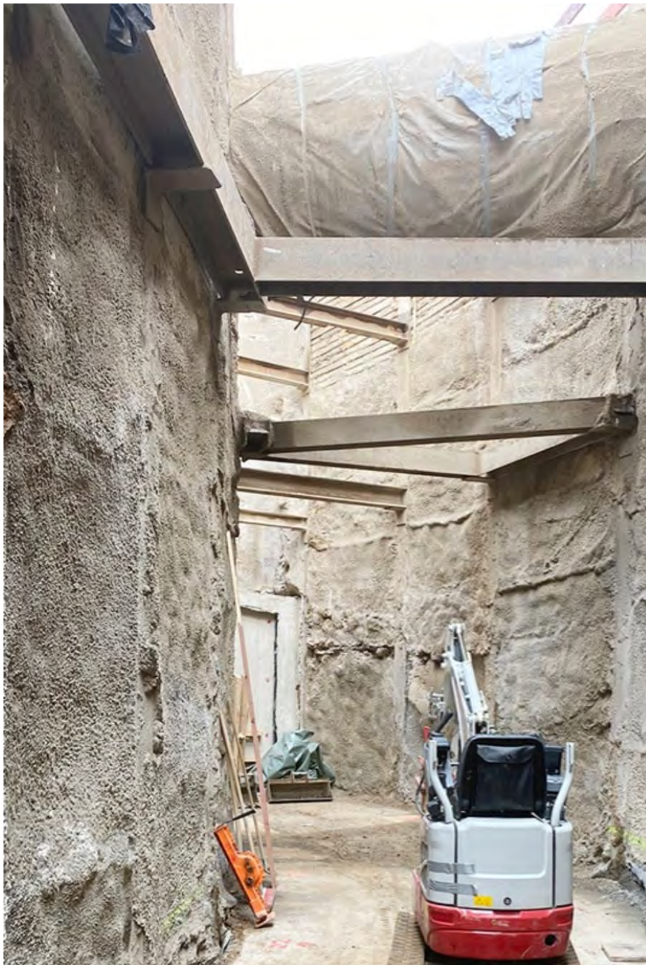
In rund 7,5 m Tiefe erfolgen die Arbeiten zum Umbau und der Erweiterung des SKU. Gut zu erkennen ist eine der beiden kreuzenden Ferngasleitungen, in deren
