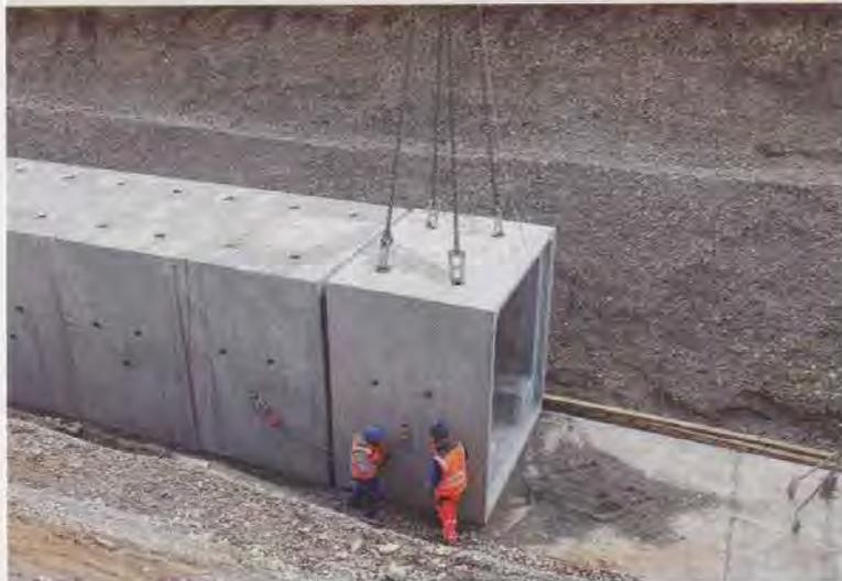
*Die Fertigteilelemente werden für das Zusammenziehen mit den Kettenzügen kurz über der Splittschicht in Schwebelage gehalten. Hierbei ist es wichtig, dass die Elemente exakt in Waage hängen.*
