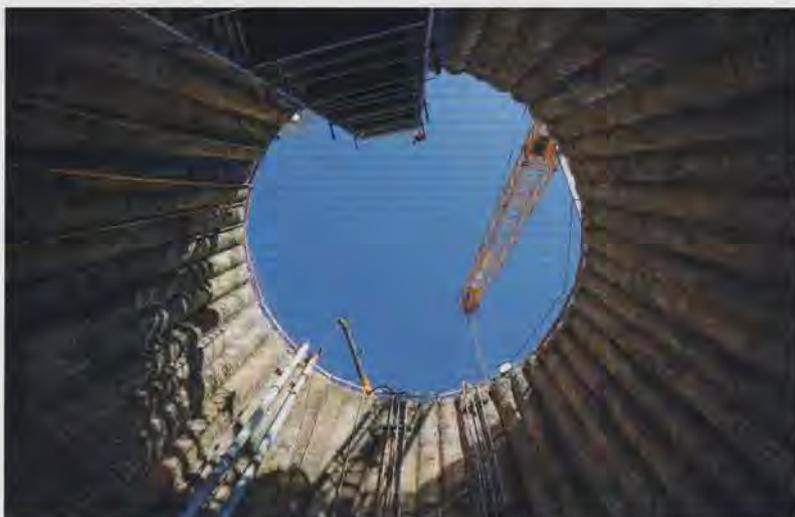
**Bild 3.** In gut 15 m Tiefe finden die Rohrvortriebsarbeiten zur Verlegung des Sammlers Untenitter statt.
