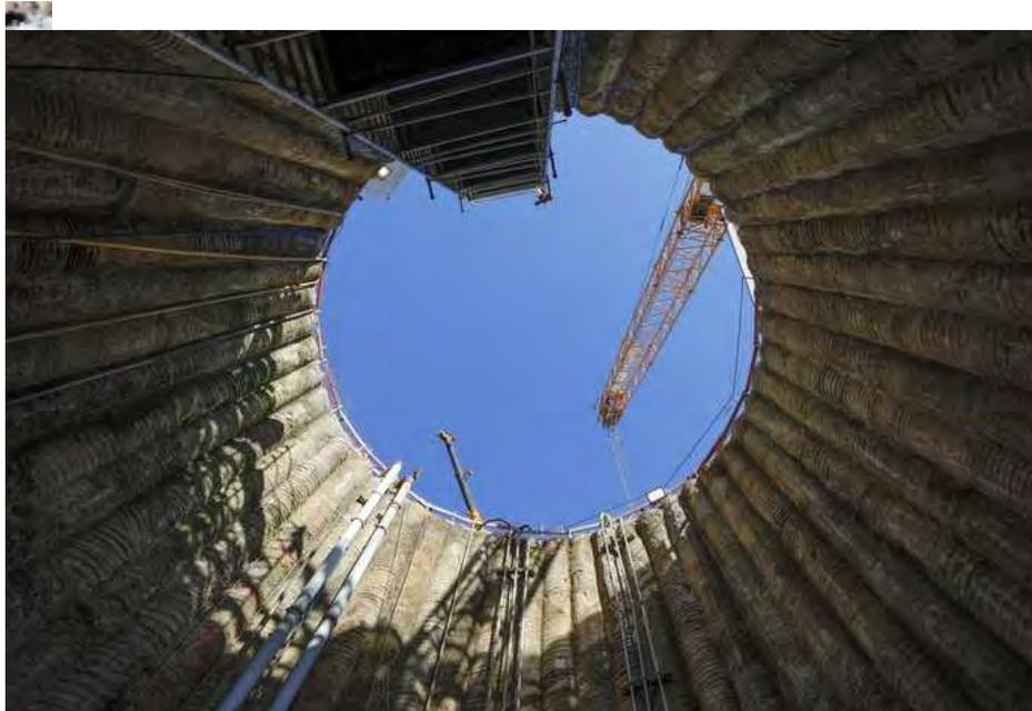
In gut 15 Metern Tiefe finden die Rohrvortriebsarbeiten zur Verlegung des Sammler Untenitter statt. | Foto: Güteschutz Kanalbau
