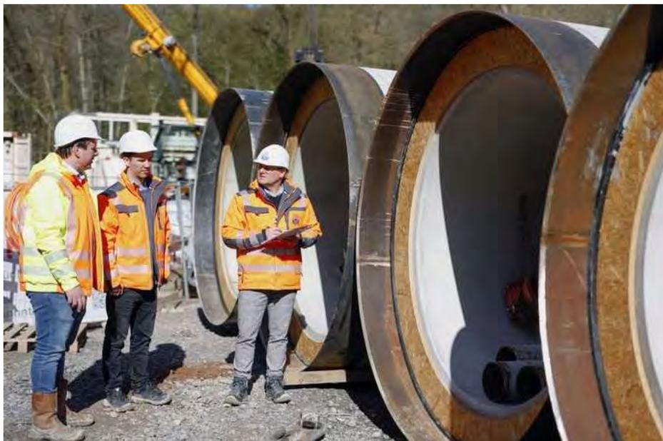
Die dickwandigen Stahlbetonrohre werden einzeln auf die Baustelle geliefert. Vor dem Einbau werden die Rohre noch einmal geprüft. | Foto: Güteschutz Kanalbau
