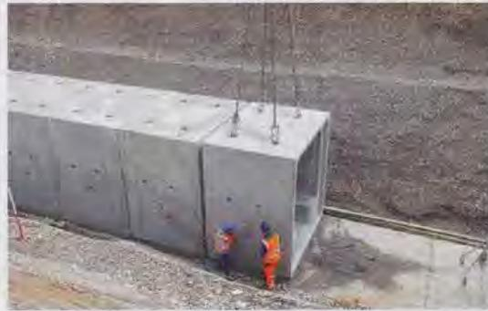
Die Fertigteilelemente werden für das Zusammenziehen mit den Kettenzügen kurz über der Splittschicht in Schwebelage gehalten. Hierbei ist es wichtig, dass die Elemente exakt in Waage hängen
