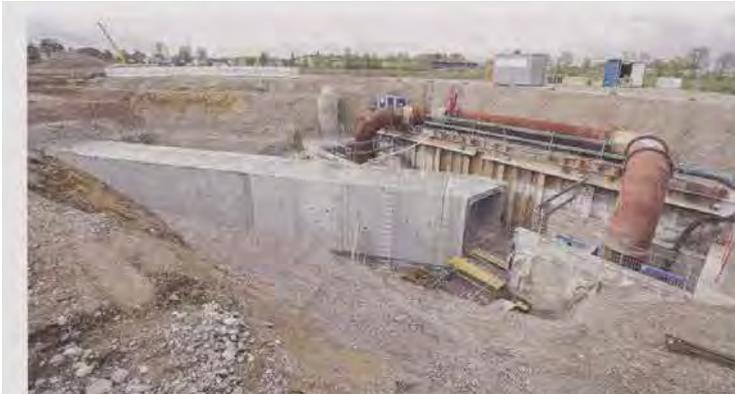
Damit der Umschluss von dem alten Kanal an den neuen in Ort betonbauweise erstellt werden kann, sorgt eine Tauchpumpe für die Aufrechterhaltung der Abwasserhaltung. Im Regenfall springt dann der Hamburger Heber ein, der das anfallende Abwasser durch das Stahlrohr DN 800 umleitet.
