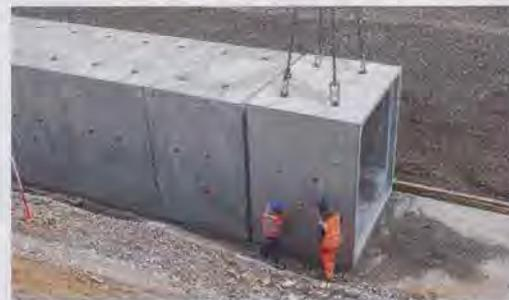
**Bild 2:** Die Fertigteilelemente werden für das Zusammenziehen mit den Kettenzügen kurz über der Splittschicht in Schwebelage gehalten. Hierbei ist es wichtig, dass die Elemente exakt in Waage hängen
