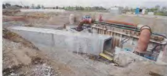
Damit der Umschluss von dem alten Kanal an den neuen in Ort-betonbauweise erstellt werden kann, sorgt eine Tauchpumpe für die Aufrechterhaltung der Abwasserhaltung. Im Regenfall springt dann der Hamburger Heber ein, der das anfallende Abwasser durch das Stahlrohr DN 800 umleitet
