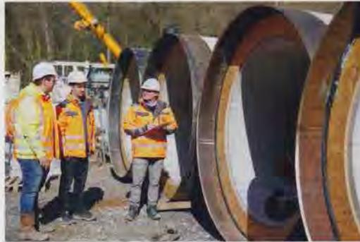
**Bild 4.** Die dickwandigen Stahlbetonrohre werden einzeln auf die Baustelle geliefert. Vor dem Einbau werden die Rohre noch einmal geprüft. (Fotos: Güteschutz Kanalbau)
