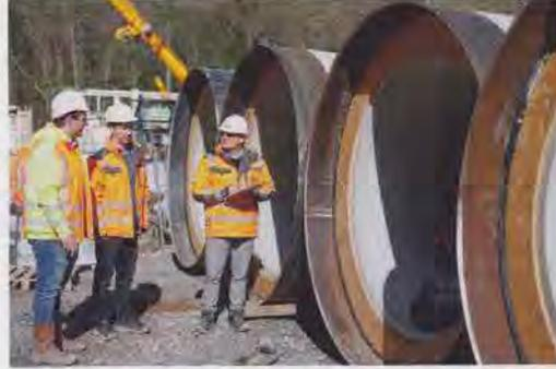
**Bild 4:** Die dickwandigen Stahlbetonrohre werden einzeln auf die Baustelle geliefert. Vor dem Einbau werden die Rohre noch einmal geprüft.
