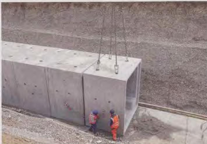
Die Fertigteillemente werden für das Zusammenziehen mit den Kettenzügen kurz über der Splittschicht in Schwebelage gehalten. Hierbei ist es wichtig, dass die Elemente exakt in Waage hängen.
