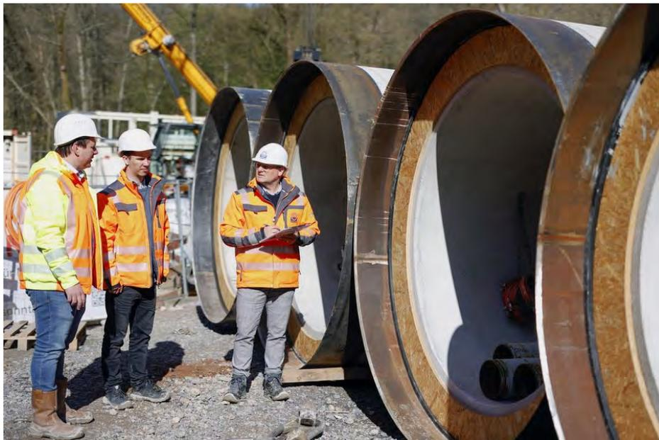
Die dickwandigen Stahlbetonrohre werden einzeln auf die Baustelle geliefert. Vor dem Einbau werden die Rohre noch einmal geprüft und die Ergebnisse werden dann dokumentiert. Foto: Güteschutz Kanalbau
