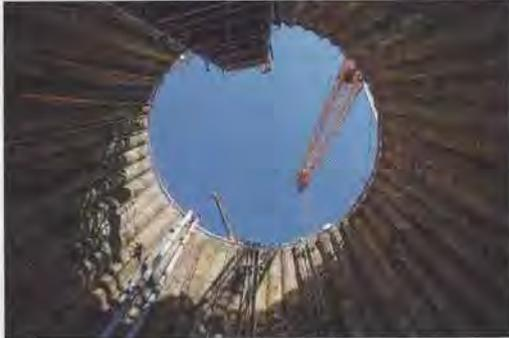
**Bild 3:** In gut 15 m Tiefe finden die Rohrvortriebsarbeiten zur Verlegung des Sammler Untertitter statt.
