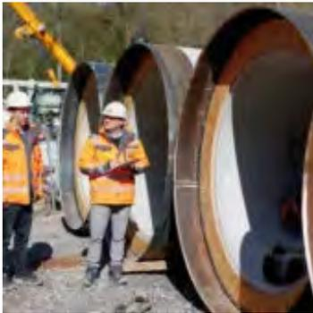
Die dickwandigen Stahlbetonrohre werden einzeln auf die Baustelle geliefert. Vor dem Einbau werden die Rohre noch einmal geprüft. (Fotos: Güteschutz Kanalbau)
