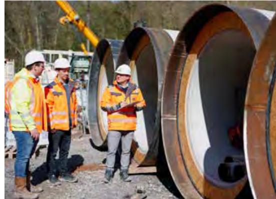
Die dickwandigen Stahlbetonrohre werden einzeln auf die Baustelle geliefert. Vor dem Einbau werden die Rohre noch einmal geprüft.
