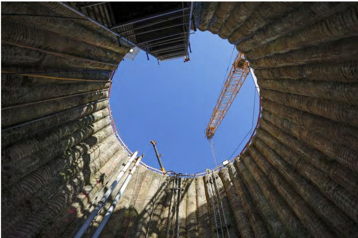
*In gut 15 m Tiefe finden die Rohrvortriebsarbeiten zur Verlegung des Sammler Untenitter statt. Foto: Güteschutz Kanalbau*
