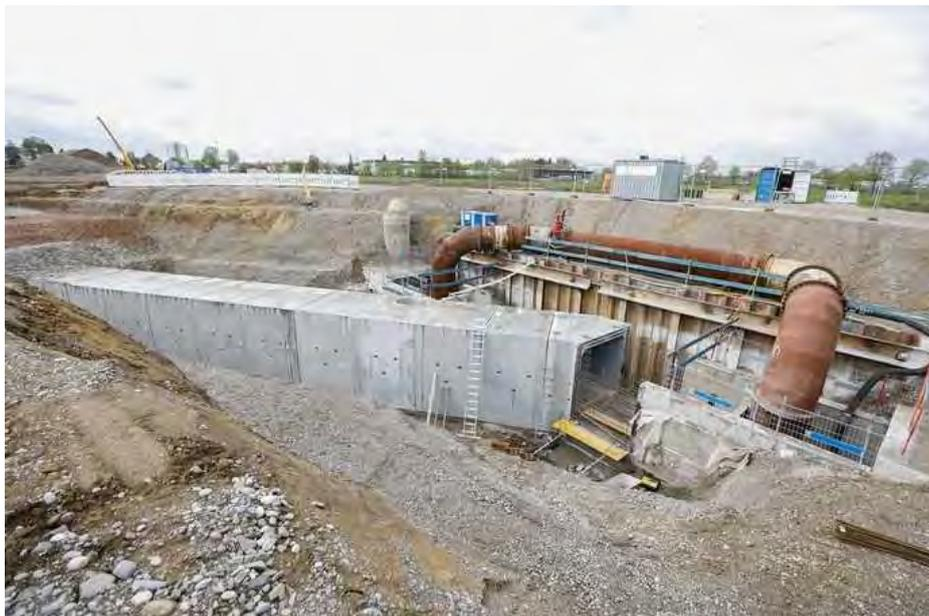
Damit der Umschluss von dem alten Kanal an den neuen in Ortbetonbauweise erstellt werden kann, sorgt eine Tauchpumpe für die Aufrechterhaltung der Abwasserhaltung. Im Regenfall springt dann der Hamburger Heber ein, der das anfallende Abwasser durch das Stahlrohr DN 800 umleitet. | Foto: Güteschutz Kanalbau
