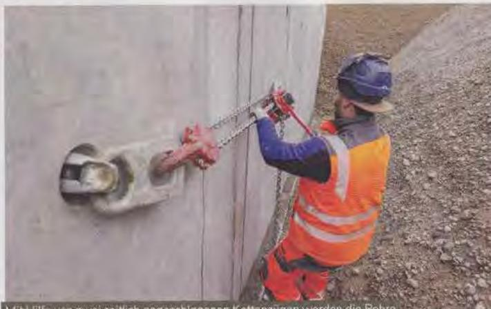
Mit Hilfe von zwei seitlich angeschlagenen Kettenzügen werden die Rohre zusammengezogen.
