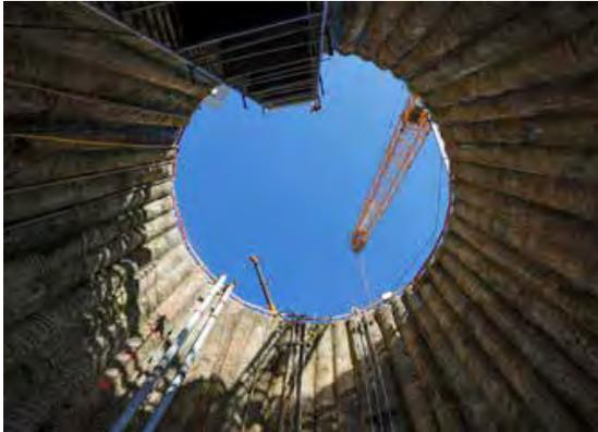
In gut 15 Metern Tiefe finden die Rohrvortriebsarbeiten zur Verlegung des Sammler Untenitter statt.
