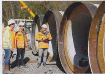
Die dickwandigen Stahlbetonrohre werden einzeln auf die Baustelle geliefert. Vor dem Einbau werden die Rohre noch einmal geprüft. Fotos: Güteschutz Kanalbau
