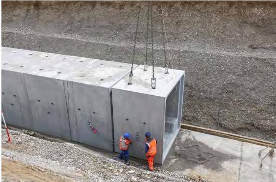
Die Fertigteilenelemente werden für das Zusammenziehen mit den Kettenzügen kurz über der Splittschicht in Schwebelage gehalten. Hierbei ist es wichtig, dass die Elemente exakt in Waage hängen. | Foto: Güteschutz Kanalbau
