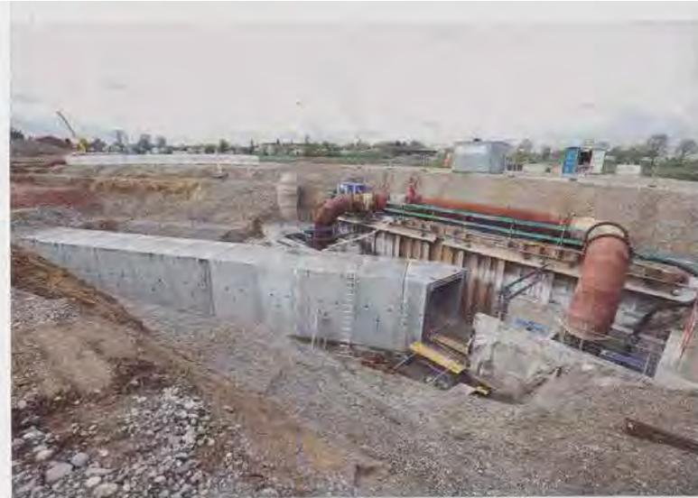
*Damit der Umschluss vom alten Kanal an den neuen in Ortbetonbauweise erstellt werden kann, sorgt eine Tauchpumpe für die Aufrechterhaltung der Abwasserhaltung. Im Regenfall springt dann der Hamburger Heber ein, der das anfallende Abwasser durch das Stahlrohr DN 800 umleitet.*
