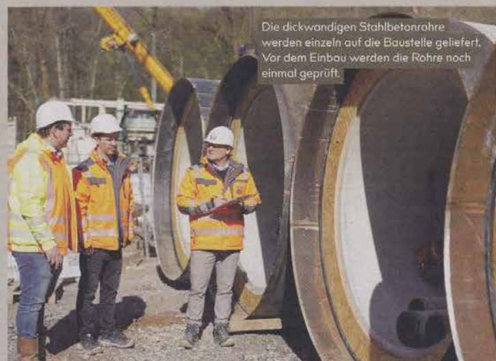
Die dickwandigen Stahlbetonrohre werden einzeln auf die Baustelle geliefert. Vor dem Einbau werden die Rohre noch einmal geprüft.
